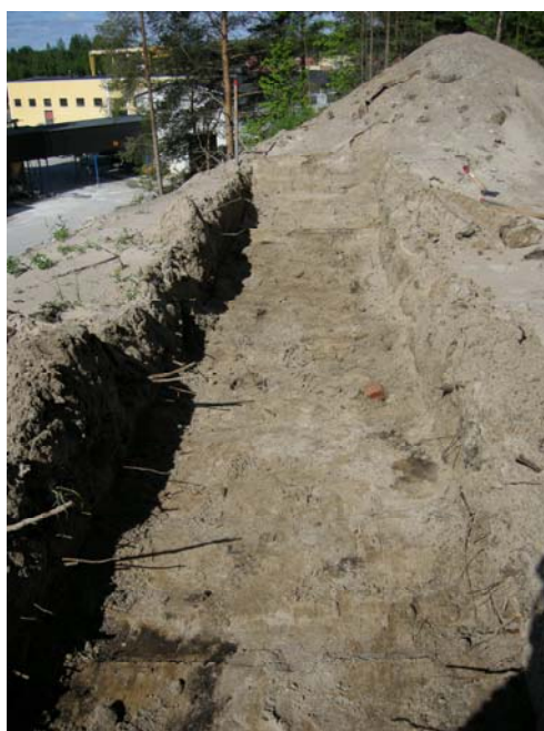
Undersökningsschaktets sista fjärdedel (från Ö räknat), längs med släntkanten vid Betongmästarnas lokaler, Öjebyns industriområde. Från Ö. Acc nr: 2009:50:15. © Norrbottens museum. Foto: Olof Östlund.
