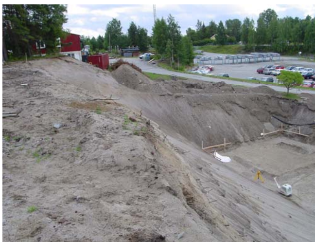
Slänt och släntkrön (undersökningsområdet) ovanför Betongmästarnas lokaler. Bilden är tagen vid besiktningen 2008, som utfördes av Norrbottens museum och Länsstyrelsen. Från V. Acc nr: 2009:50:25. © Norrbottens museum. Foto: Gunilla Edbom, Länsstyrelsen i Norrbottens län.
