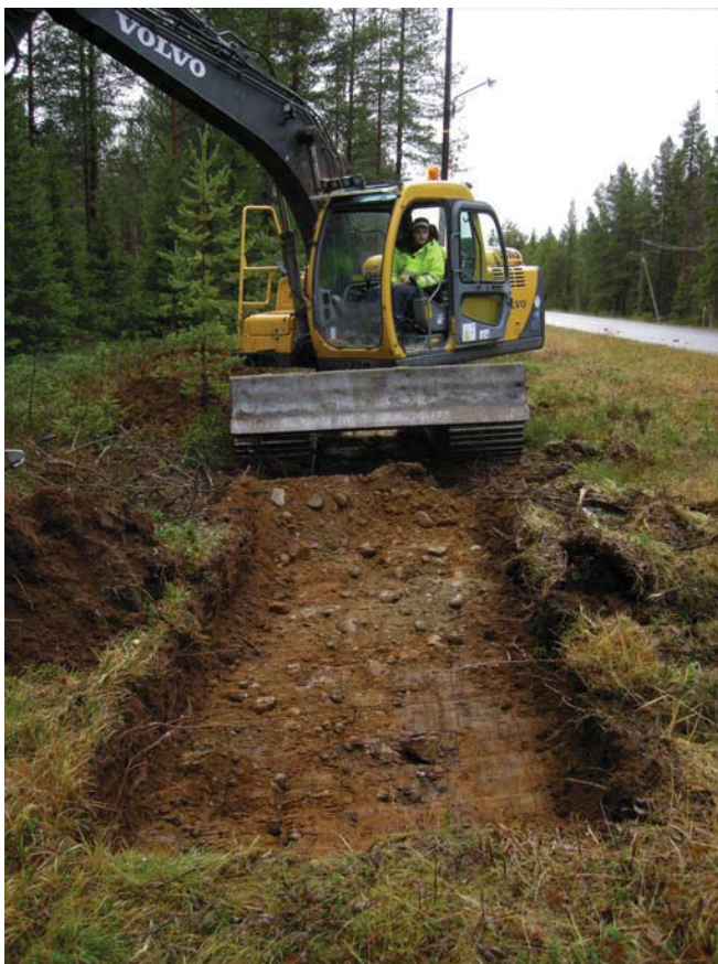
Ett av de 6 lägena för grävmaskin. Grävmaskinsschakt vid väg 395, i södra utkanten av Lovikka nära Raä Junosuando 184:1 (Fyndplats) där ett nordbottniskt redskap påträffats i ett potatisland. Nbm acc nr 2012:70:50 © Norrbottens museum. Foto från S. Fotograf: Olof Östlund.
