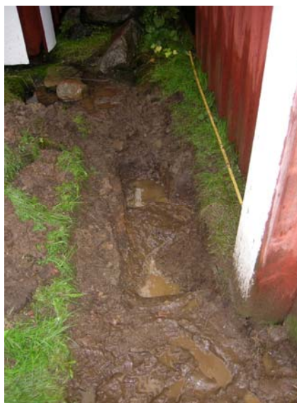
Schakt 4 (Nbm acc nr 2011:130:, Foto: Olof Östlund © Norrbottens Museum)
