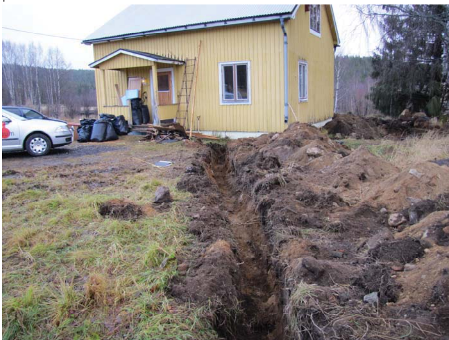
Nbm acc nr 2010:259:010 © Norrbottens museum. Bergvärmeschaktets norra del. Foto från V. Fotograf: Nils Johansson.
