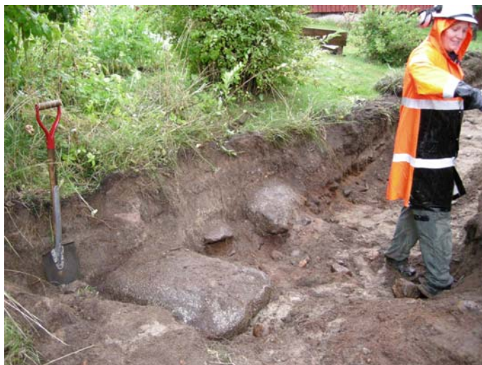
Syllstenarna under buskarna i blombänken. Den ljusare sanden till höger om syllstenarna är fyllnadsmassor till schaktet för en VA-ledning. Med på bilden är också Mirjam Jonsson. Foto Olof Östlund. Nbm acc nr 2009:94:13 © Norrbottens museum.
