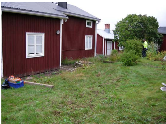
Platsen för schakt 1 innan grävning. Olof Östlund i gul jacka står på högra sidan av kullen under bkombänken. Schaktet drogs från högnet på huset ungefär till den plats där fotografen står. Foto Mirjam Jonsson. Nbm acc nr 2009:94:05 © Norrbottens museum.
