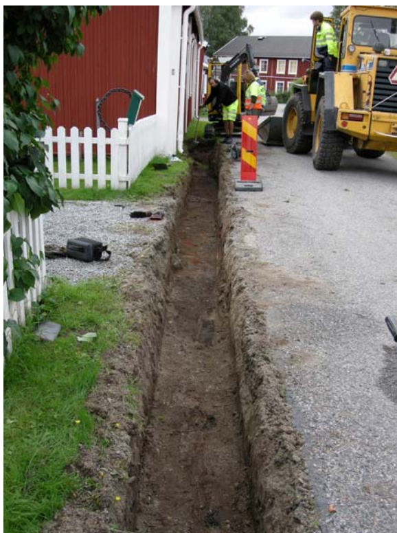
Huvudschakt Ö om Häradsvägen, 18-30 m in i schaktet. Det svarta som börjar vid grusinfarten är kulturlager. Foto: Olof Östlund © Norrbottens museum. Nbm acc nr 2008:279:065
