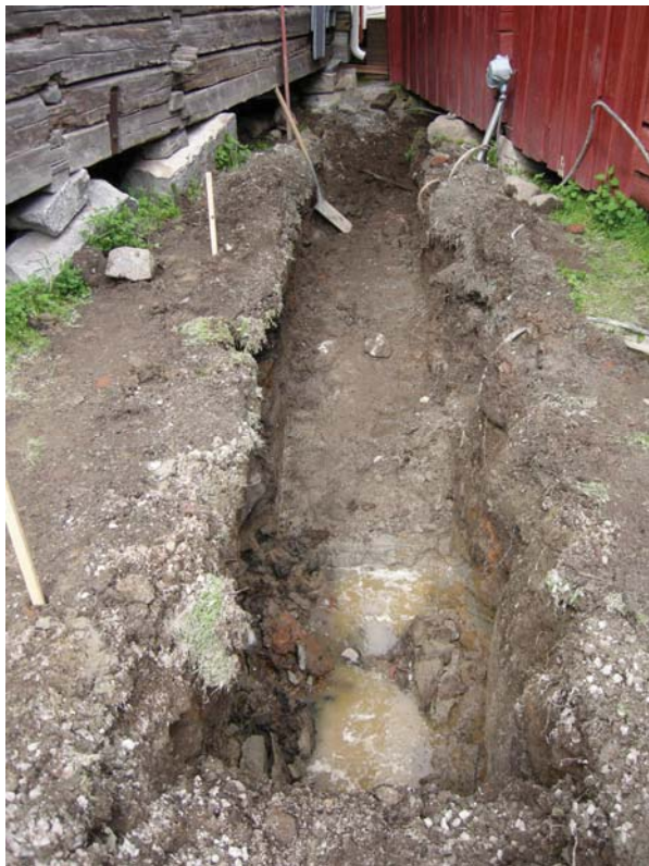
Schakt i område 2, mellan kyrkstugorna i innergårdens N hörn. Vid grävning av schaktet började vatten strömma in pga av den dåliga dräneringen runt stugorna. Bilden är tagen från S. Acc nr 2008:103:07. Fotograf: Mirjam Jonsson. Norrbottens museum ©
