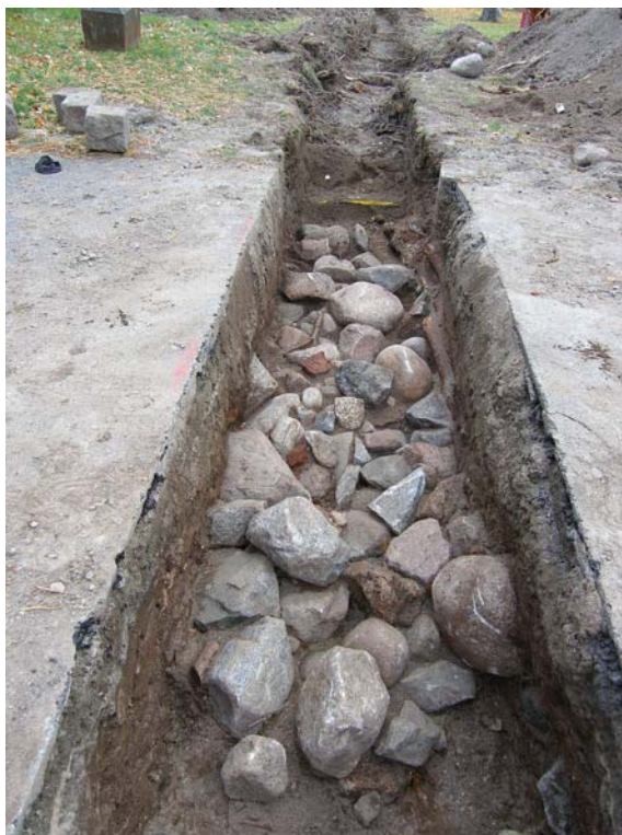
Fig 2. Stenlagd väg under befintlig. Från Ö. ©Norrbottens museum acc. nr 2010:161:022. Foto John Molin
