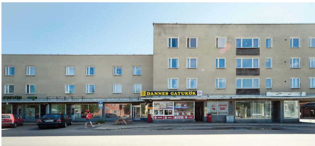
Focuslängans byggnadskroppar som även de är förskjutna i förhållande till varandra samt är olika höga. Nbm acc nr. 2010_188_017
