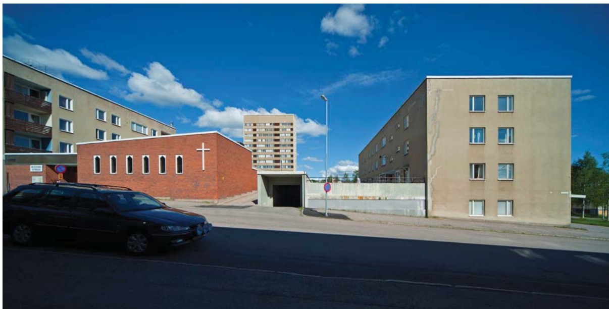
I mitten av tronen höghuset, till väster i bild skymtar focuslängan och framför den missionskyrkan med sina tegelröda fasader. Till höger syns lamellhuset och mellan den och kyrkan ser man uppfarten till gården och nedfarten till parkeringsdäcket. Nbm acc nr. 2010_188_047
