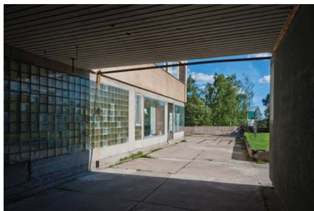
Focushusets bottenvåning har stora skyltfönster och partier av glasbetong som gör att byggnaden tycks sväva. En ny teknik som möjliggjorts av att yttreväggarna inte längre är bärande. Nbm acc nr. 2010_188_180
