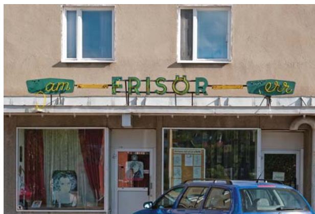
En av de vackra neonskyltarna finns kvar i original., om än i dåligt skick. Ritningarna i original finns på Stadsbyggnadskontoret i Gällivare. Nbm acc nr. 2010_188_197
