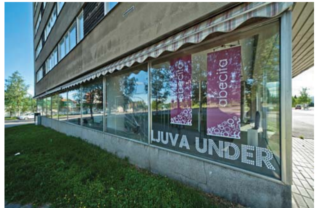
Glasfönstren som på bottenvåningen gör att byggnaden tycks sväva. Nbm acc nr. 2010_188_209
