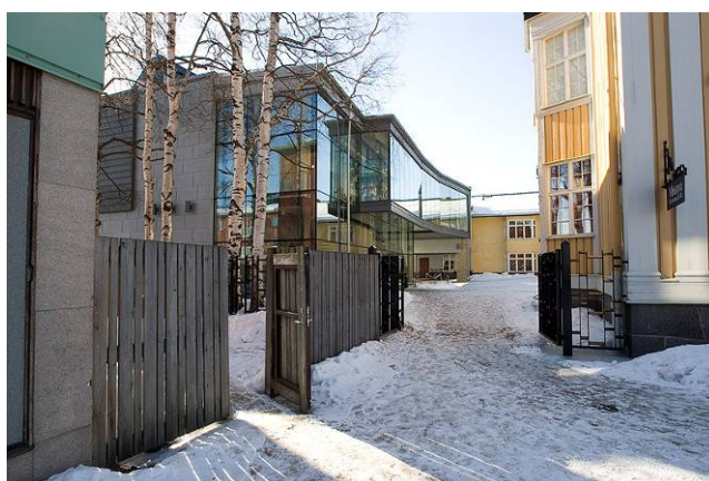
Minerva skymtar fram i det sydvästra hörnet av Haparanda torg. © Norrbottens museum Fotograf: Daryoush Tahmasebi
