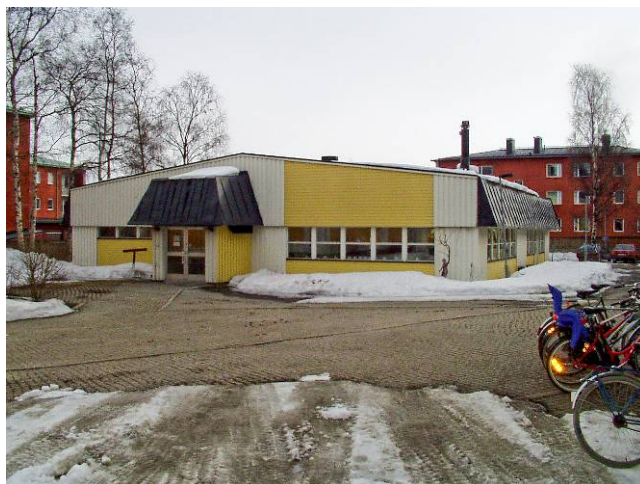
Den gamla matsalen före om- och tillbyggnad. © MAF Arkitektkontor AB.
