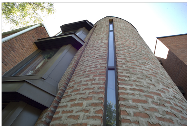
Trapphuset på nordostfasaden.
