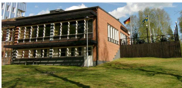
Restaurangflygeln som byggts till och förändrats i etapper. Nbm acc.nr 2006:33:13
