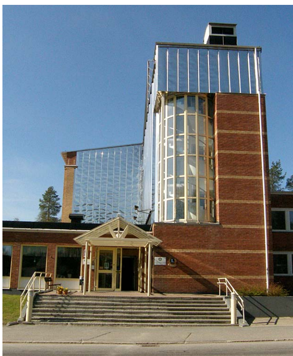
Det centrala partiet från nordost med den breda trappan och entrén samt till höger i bild den höga huskroppen med inglasat trapphus och krönande plåtinklädnad. Nbm acc.nr 2006:33:02
