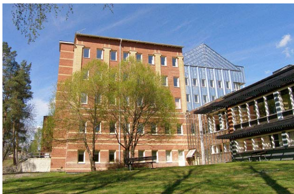
Från vänster nordvästflygeln, den plåtklädda påbyggnaden och köksdelen som renoverades och försågs med ny fasadbeklädnad i falsad plåt vid den stora om- och tillbyggnationen i 1980-talets slut. Foto från söder. Nbm acc.nr 2006:33:15
