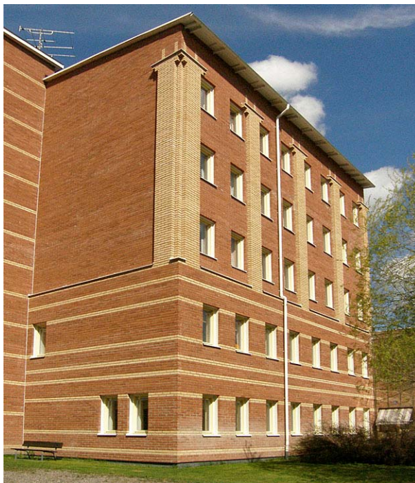
Västflygeln med kapitälförsedda lisener och mönstermurade fasader. Till vänster i bild skymtar det utskjutande trapphuset. De storskaliga fasadelementen och byggnadens kubiska form ger den ett mycket robust uttryck. Foto från söder Nbm acc.nr 2006:33:16
