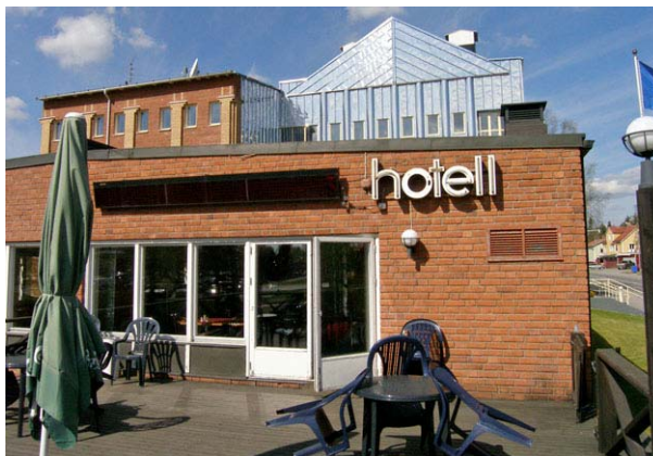
Altandörrar är sannolikt tillkomna under 1980-talet, altanen troligtvis senare. Fotografi från sydost. Nbm acc.nr 2006:33:10
