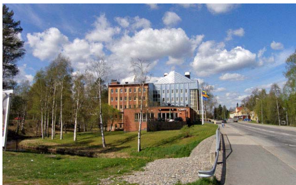
Polar Hotel från sydost. Till vänster det grönområde och den å som finns söder om byggnaden. Till höger i bild Storgatan som löper mellan Älvsbyns centrum och järnvägsstationen. Nbm acc.nr 2006:33:05
