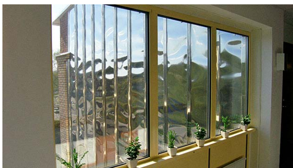
Fönsterparti i korridor i den centrala delen. Nbm acc.nr 2006:35:04
